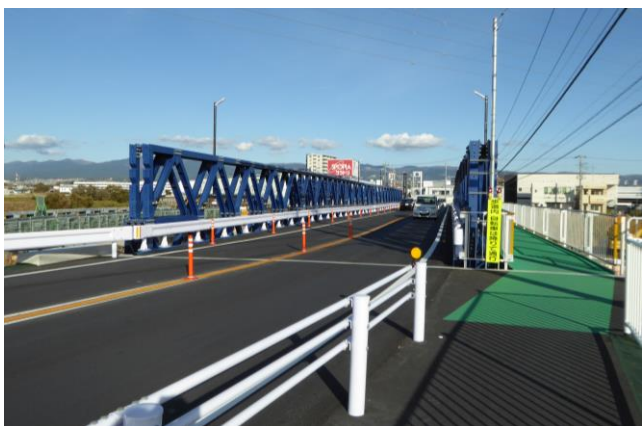
10/16 (月) の午後 3 時に仮橋が開通した黄瀬川大橋
