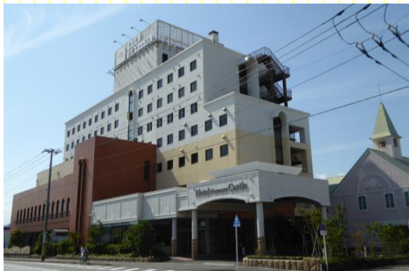
新型コロナの影響で廃業した後に東邦大学看護学部の入居が決定したホテル跡地
